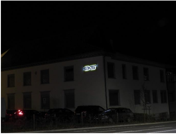
EKS-Gebäude, Hausecke Rheinuferstrasse
